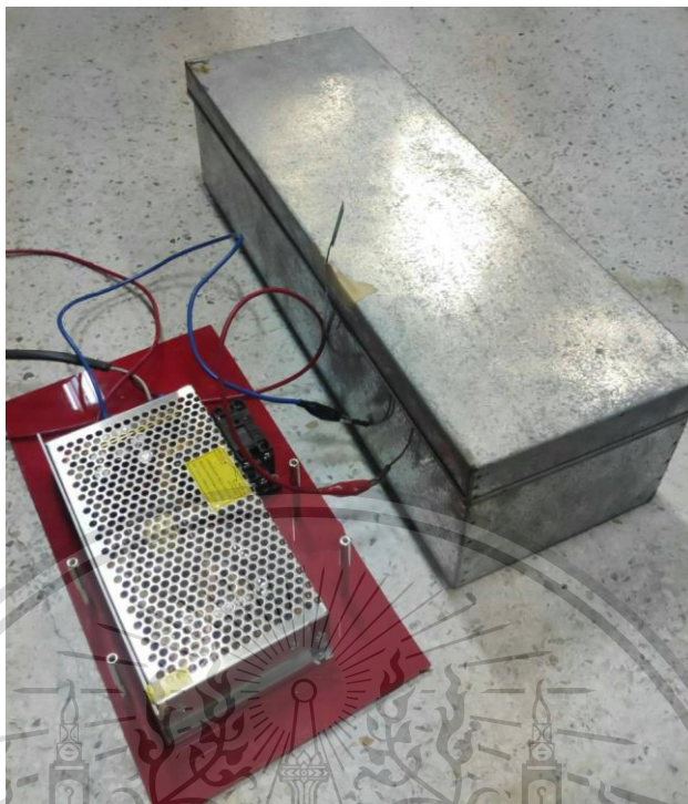
รูปที่ 4.33 การทดสอบระบบควบคุมการทำงานของชุดเครื่องกำเนิดไฟฟ้าจากระยะไกล กรณีที่อุปกรณ์ถูกใส่ในกล่องเหล็กโดยสายรับสัญญาณอยู่ภายนอก
