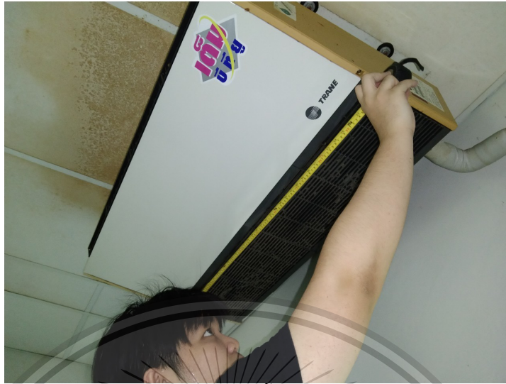
รูปที่ 4.1 การวัดพื้นที่ช่องลมกลับ
