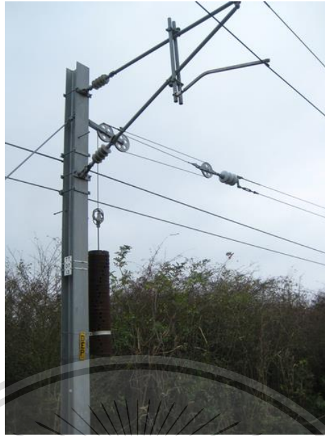
รูปที่ 2.13 ระบบกันสะเทือนเหนือศีรษะ ระบบต็มน้ำหนักและรอกออกแบบมาเพื่อรักษาความตึงของ ลวดสัมผัส
