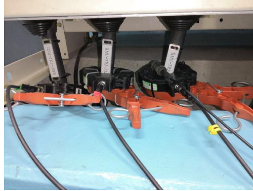
รูปที่ 3.7 HFCT sensor
