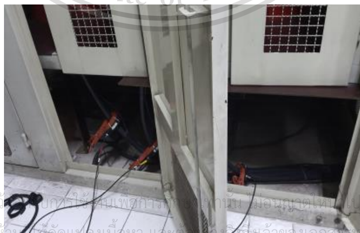
รูปที่ 4.7 การตรวจจับ PD ด้วยเซนเซอร์ HFCT ที่ Distribution transformer (TR-2 mall 3)
