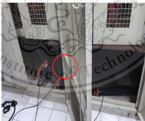
รูปที่ 3.17 การติดตั้ง HFCT sensors
