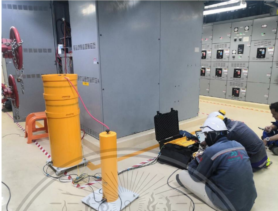
รูปที่ ข.3 การติดตั้งชุดทดสอบ Damped AC สำหรับการทดสอบสายเคเบิล 6.9 KV
