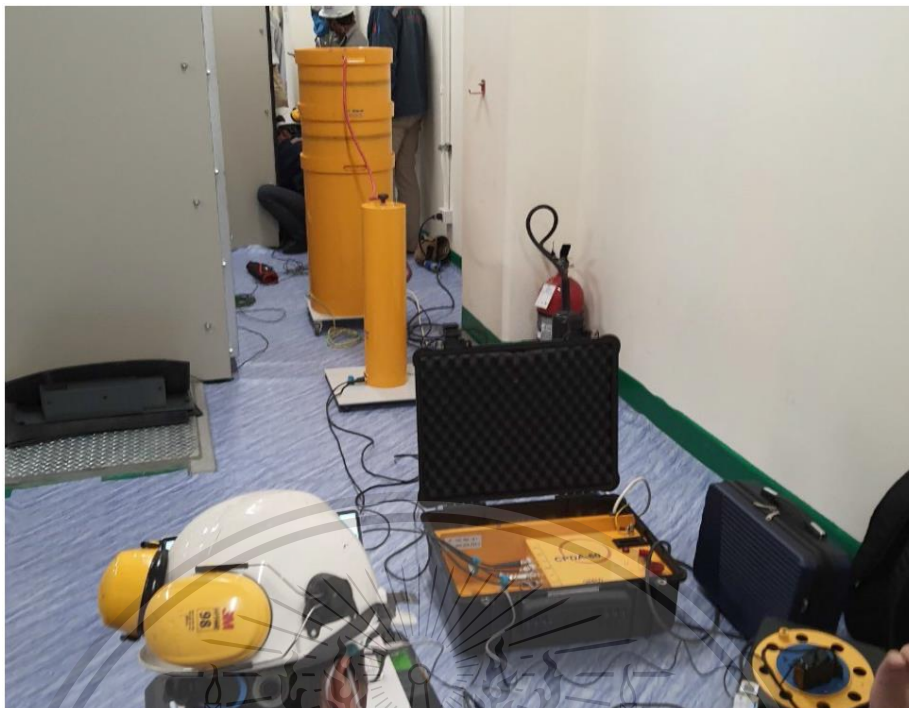
รูปที่ ข.1 การติดตั้งชุดทดสอบ Damped AC สำหรับการทดสอบเคเบิล 22 kV
