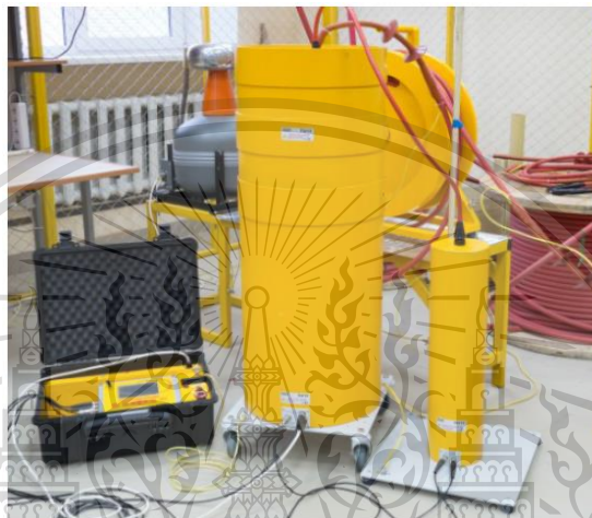
รูปที่ 3.1 แหล่งจ่ายแรงดันทดสอบ Damped AC 35 kV
