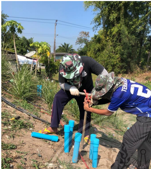
รูปที่ 3.2.2(ก) ขุดหลุมเพื่อติดตั้ง Sensor
