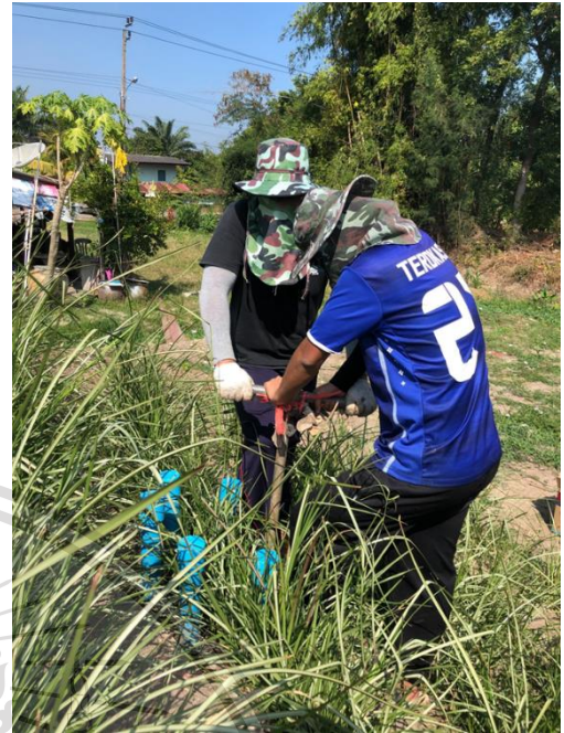
รูปที่ 3.2.2(ข) ติดตั้ง Sensor
