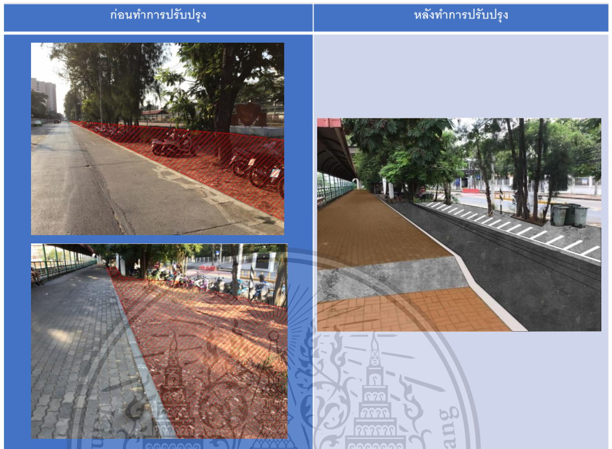
รูปที่ 4.2 แสดงการเปรียบเทียบสภาพก่อน-หลังปรับปรุงที่จอดรถบริเวณป้ายหยุดรถไฟพระจอมเกล้า
