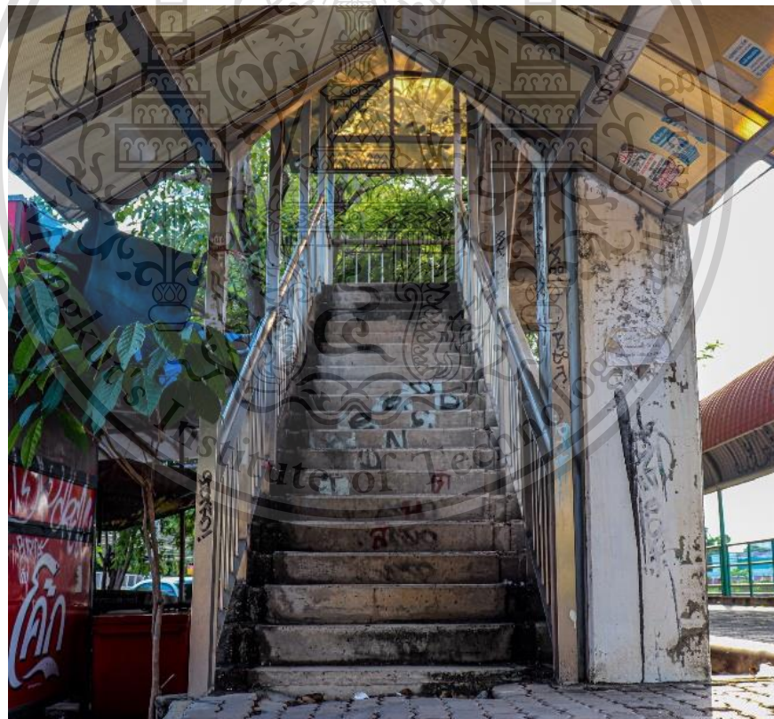
รูปที่ 3.11 แสดงสภาพทางขึ้นสะพานลอยที่อยู่บริเวณสถานีพระจอมเกล้า
