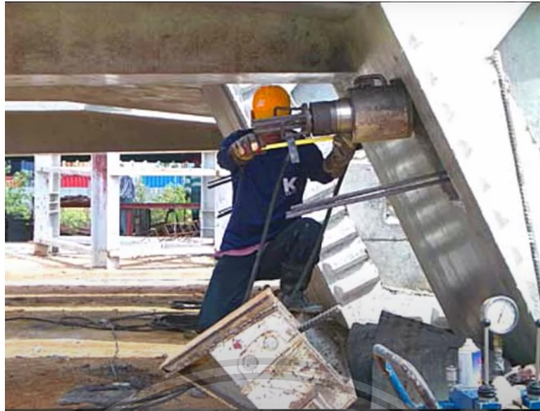
รูปที่ 2.17 การดึงลวดอัดแรงขั้นแรก (Initial Stressing)
