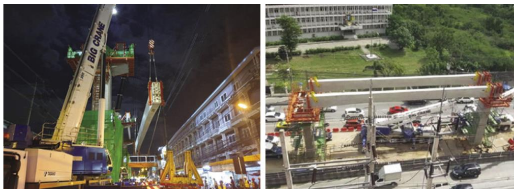
รูปที่ ข.6 การติดตั้ง Guideway Beam ที่หน้างาน
