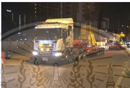
รูปที่ 2.3 การขนเคลื่อนย้ายคานรูปตัวไอของโครงการรถไฟฟ้าสายสีชมพู
