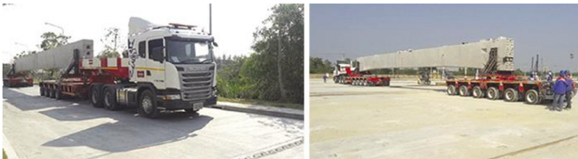
รูปที่ ข.8 การขนส่งชิ้นส่วนคานทางวิ่ง Guideway Beam ด้วยรถเทรลเลอร์ไปที่หน้างาน
