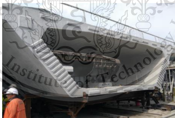
รูปที่ 2.6 การหล่อชิ้นส่วนของคานสะพานรูปกล่องที่โรงงาน (Precast Segmental Viaduct)
