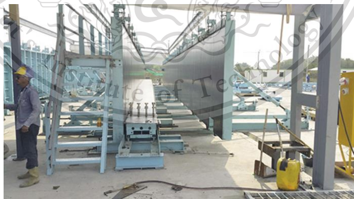
รูปที่ ข.9 รูปแสดงการเตรียมแบบหล่อ Guideway Beam
