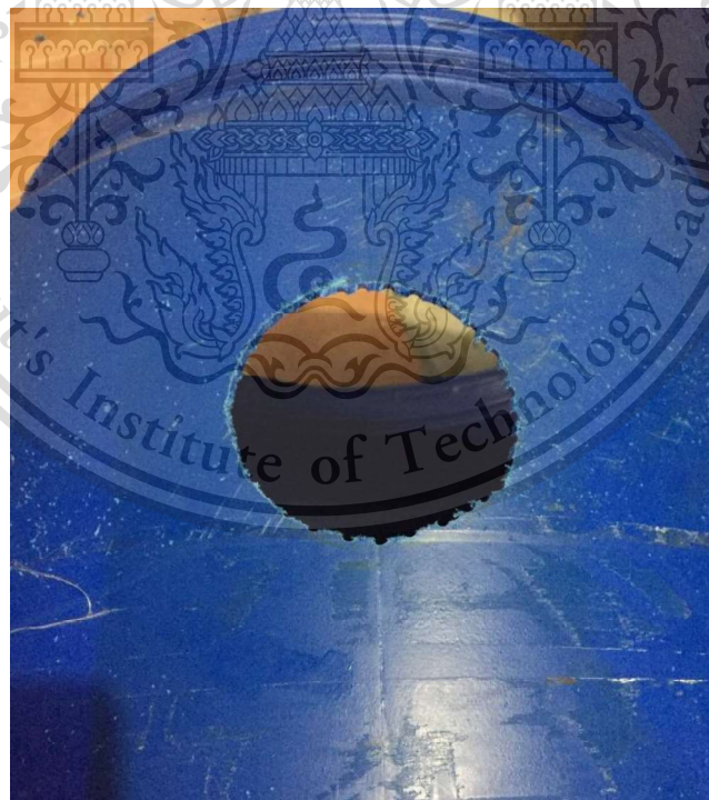
รูปที่ 3.9 รูสำหรับท่อขนาด 4 นิ้ว หลังจากเจาะด้วยสว่าน
