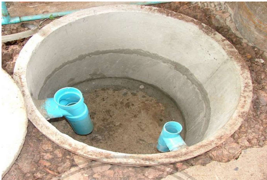
รูปที่ 2.4 แสดงถังดักไขมันแบบวงขอบซีเมนต์ (กระทรวงวิทยาศาสตร์และเทคโนโลยีและสิ่งแวดล้อม).
