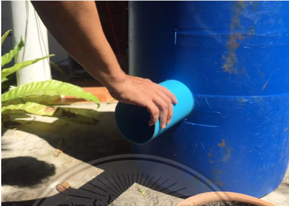
รูปที่ 3.15 ประกอบท่อที่เตรียมไว้เข้ากับตัวถังพลาสติกที่เจาะรูแล้ว
