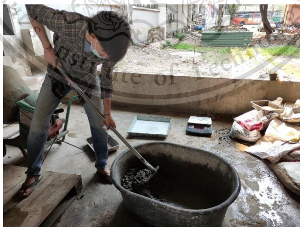
รูปที่ 3.14 ทำการผสมคอนกรีต
