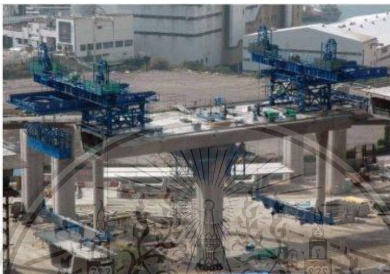
รูปที่ 2.3-5 แสดง lifting frame ที่ติดตั้งบนสะพาน
