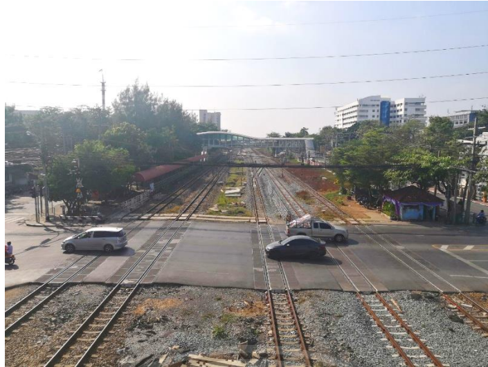
รูปที่ 4.2 มิวทางบริเวณทางรถไฟ
