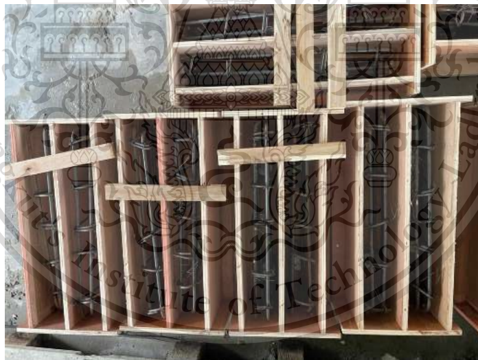
รูปที่ 3.25 นำเหล็กเสริมใส่ลงในแบบหล่อตัวอย่าง
