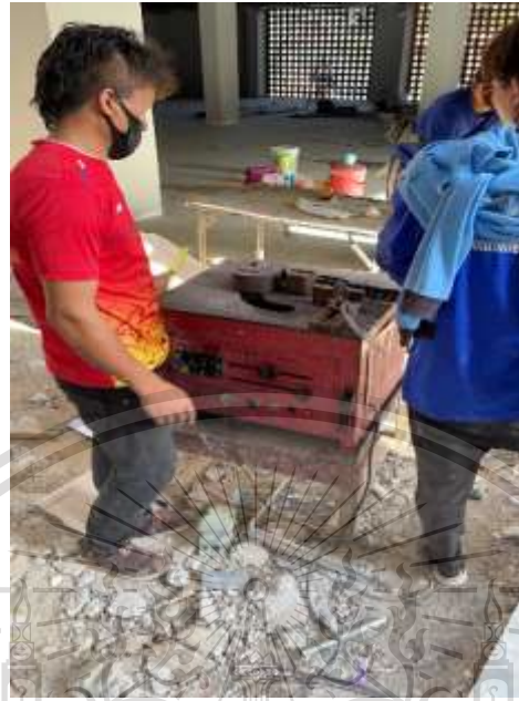
รูปที่ 3.22 การตัดและตัดเหล็กเสริม
