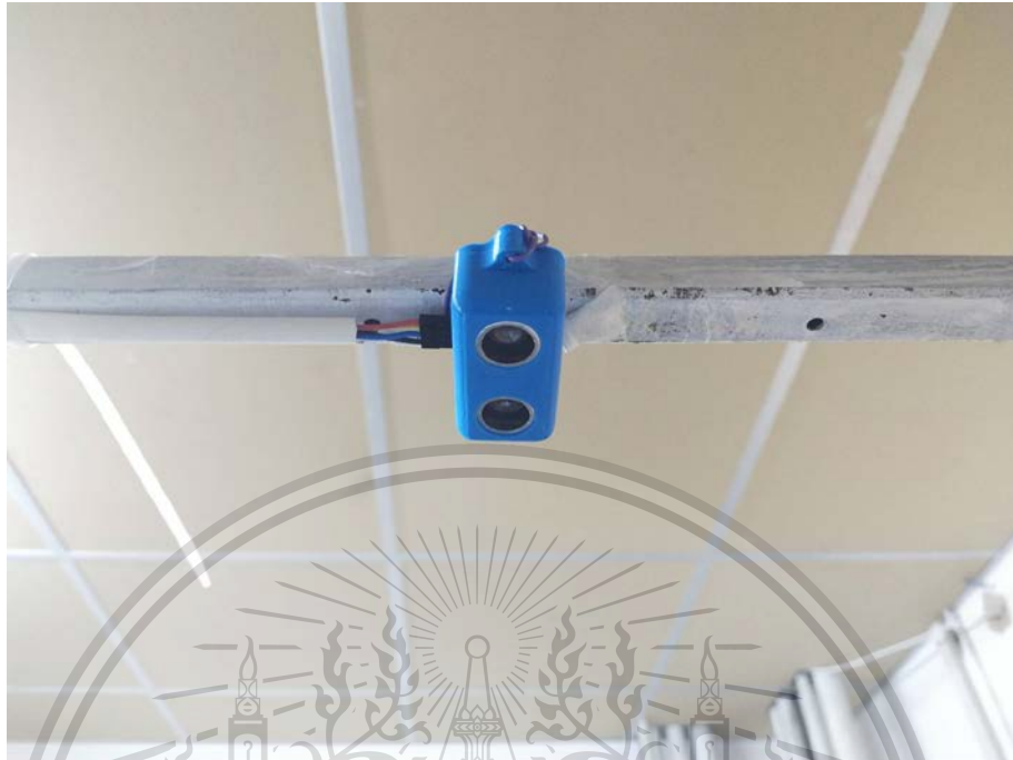
รูปที่ 3.112 การติดตั้งเซนเซอร์วัดส่วนสูงลงบนโครงของระบบ
