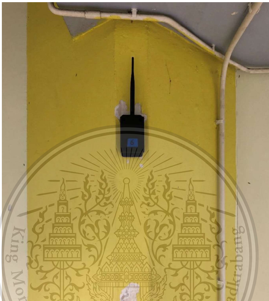
รูปที่ 5 ตำแหน่งการติดตั้งอุปกรณ์ส่งสัญญาณ
