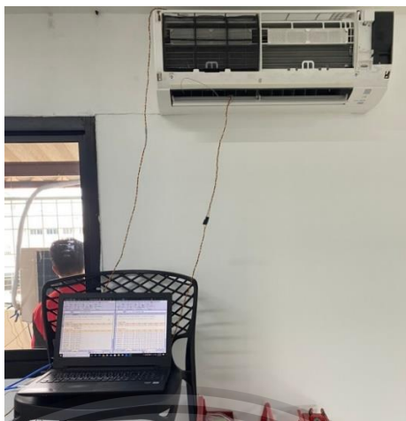
รูปที่ 4.17 ทดสอบเครื่องปรับอากาศที่สถานะปกติ
