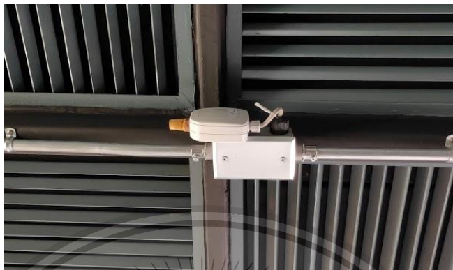
รูปที่ 20 เซนเซอร์ตรวจจับความชื้นสัมพัทธ์ในอากาศ
