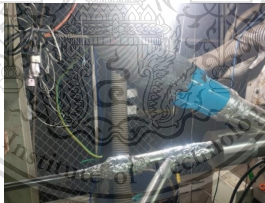
รูปที่ 3. 16 ท่อชนิดพลาสติกใช้ข้อลด 2 ½ เป็น 2 นิ้ว และใช้ซิลิโคนเป็นตัวเชื่อม
