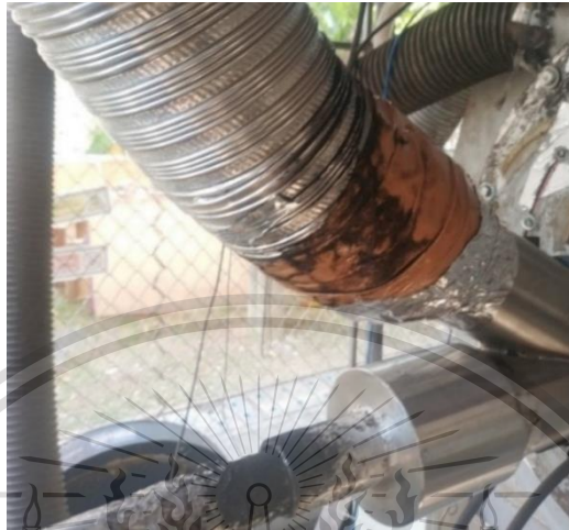
รูปที่ 3. 15 การรั่วของเชื้อเพลิงผงบบริเวณข้อต่อของท่อ
