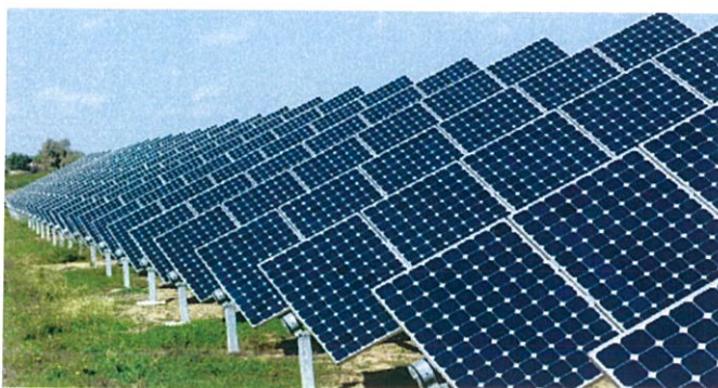
รูปที่ 8.23 แสดงภาพ Solar Panels
