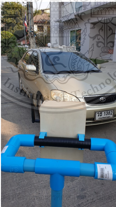
รูปที่ ก.4 การติดตั้ง Module (ต่อ)
