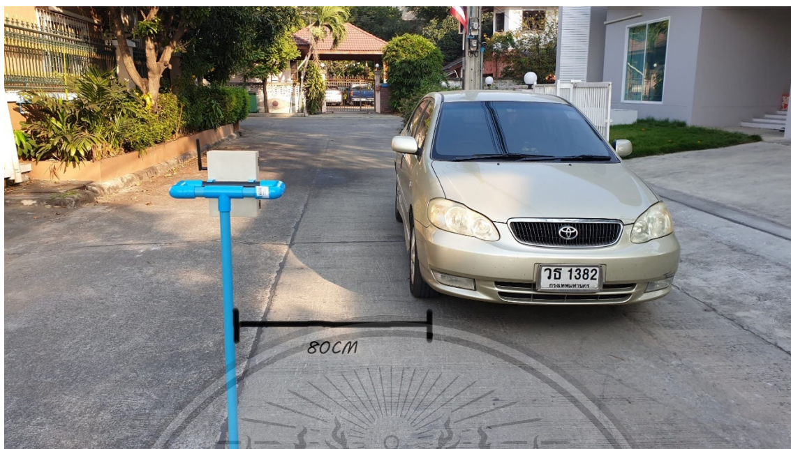
รูปที่ ก.3 การติดตั้ง Module (ต่อ)
