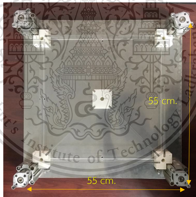
รูปที่ 3.12 การติดตั้งเสาและเชื่อมอะคริลิกเชื่อมกับเสาทั้งหมด
