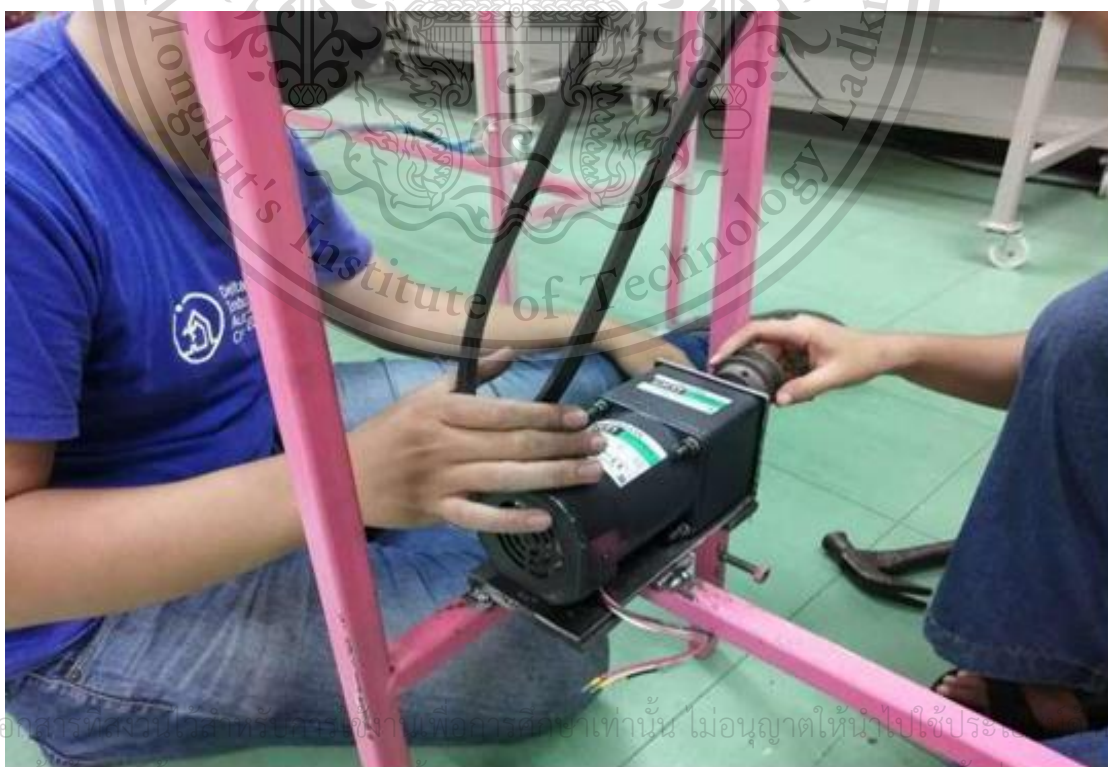
รูปภาพที่ 3-18 ทำการประกอบมอเตอร์เข้ากับชุดของสายพานลำเลียง
