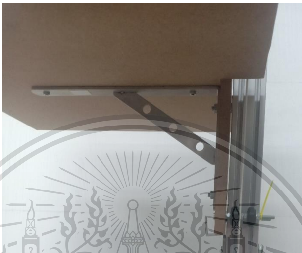
รูปที่ 4.2 สแตนเลสรับชั้นที่ใช้รองรับแผ่นไม้ มีความแข็งแรงเพียงพอเมื่อบรรจุอาหาร
