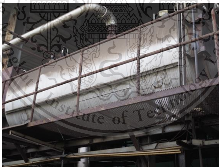
รูปที่4.3 หม้อไอน้ำแบบท่อไฟ
