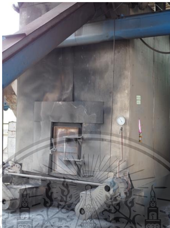
รูปที่4.2 หม้อไอน้ำแบบท่อน้ำ
