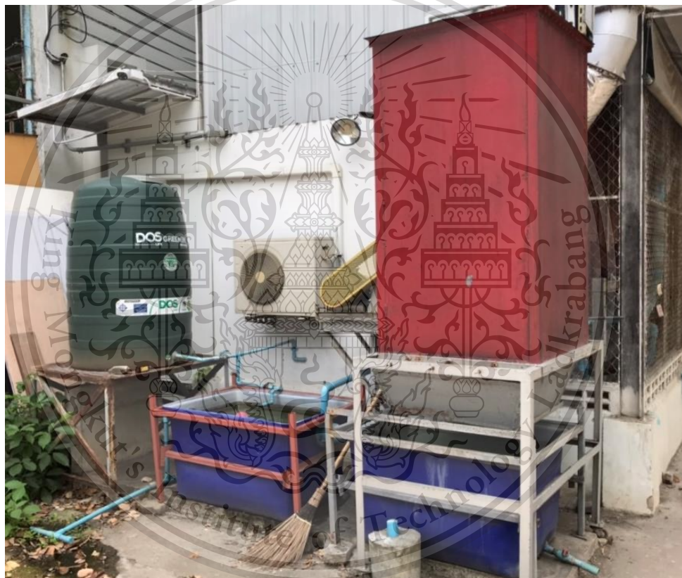
รูปที่ 4.13 บ่อพักน้ำ
