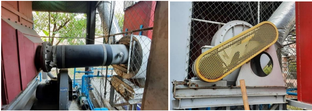
รูปที่ 4.12 ทางออกของระบบบำบัดไอเสีย (ซ้าย) พัดลมดูดไอเสีย (ขวา)
