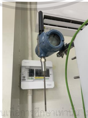
รูปที่ 2.9 ทรานสมิตเตอร์วัดอุณหภูมิแบบไร้สาย รุ่น 648
