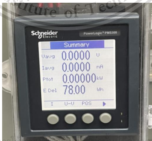
รูปที่ 2.7 ดิจิตอลมิเตอร์ รุ่น Power Logic™ PM5300
