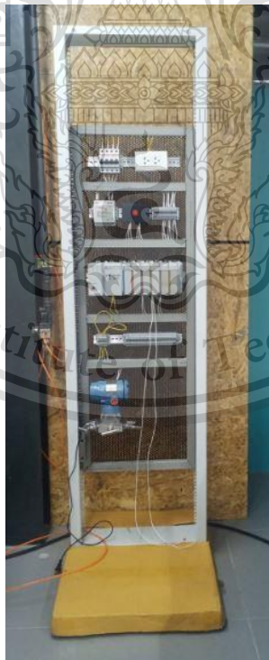
รูปที่ 4.1 ภาพอุปกรณ์หลังจากการจัดทำเสร็จสิ้น
