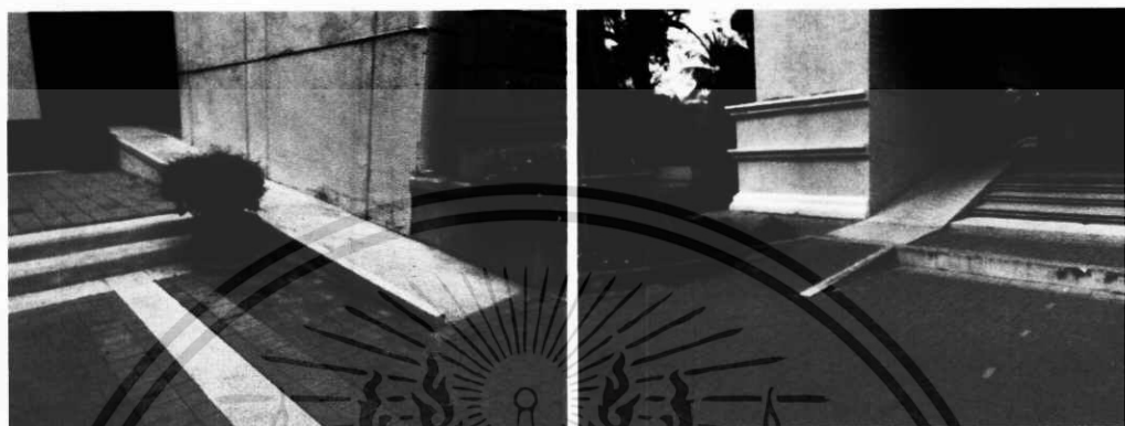
ภาพที่ 4.3 ภาพแสดงทางลาดเข้าสู่ตัวอาคารสำหรับกิจกรรมการเรียนการสอน ก่อสร้างก่อนปีพ.ศ.2548 ที่มีอยู่ในปัจจุบันภายในมหาวิทยาลัย
