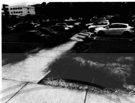
ภาพที่ 2.4 แสดงให้เห็นการเชื่อมต่อทางเดินเท้าด้วยทางลาดจากลานจอดรถ ทำให้ไม่เป็นอุปสรรคต่อการเข้าถึงของคนพิการ ที่มา: ศรีดาราทิเพียร, 2558
