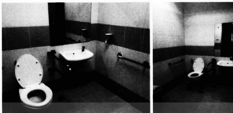
ภาพที่ 4.6 ภาพแสดงห้องน้ำสำหรับคนพิการที่อยู่ภายในอาคารที่ก่อสร้างหลังปีพ.ศ.2548
