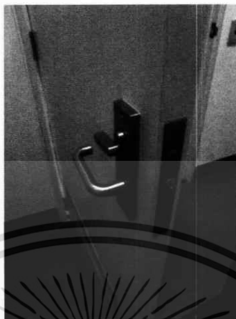
ภาพที่ 2.18 การใช้มือจับแบบก้านโยกกับประตูห้องน้ำ ที่มา: ศรีดาราทิเพียร, 2558
