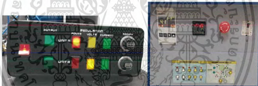
รูปที่ 3.8 แสดงความดันในห้องเคลือบบนแผงควบคุม
