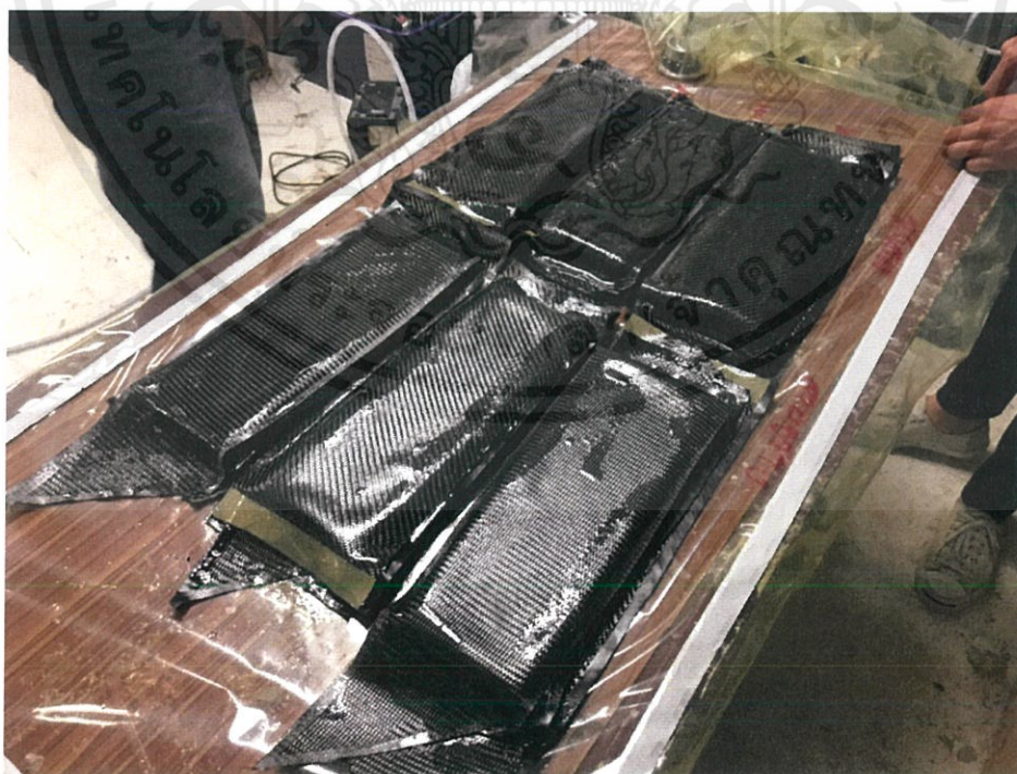
รูปที่ 4.8 แสดงการติด Sealant Tape หลังจากวางผ้าคาร์บอนสลักแผ่นโฟม
