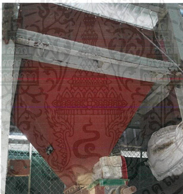
รูปที่ 3.3 ลักษณะถังพักเชื้อเพลิงชีวมวล (hopper)
