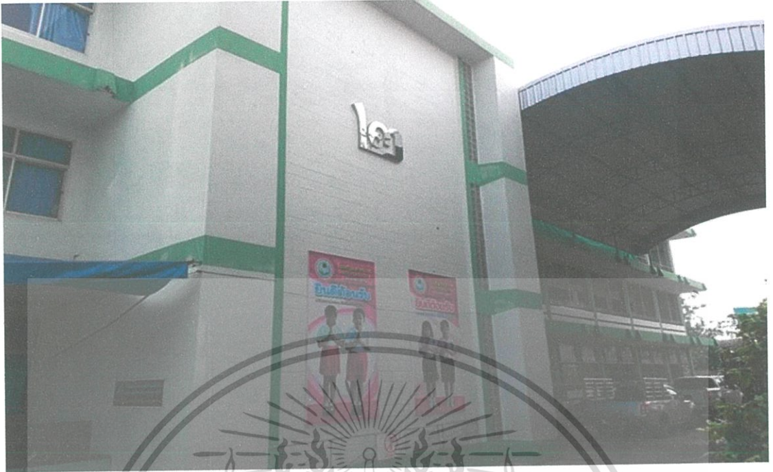
รูปที่ ก. 3 อาคารเรียน 2
