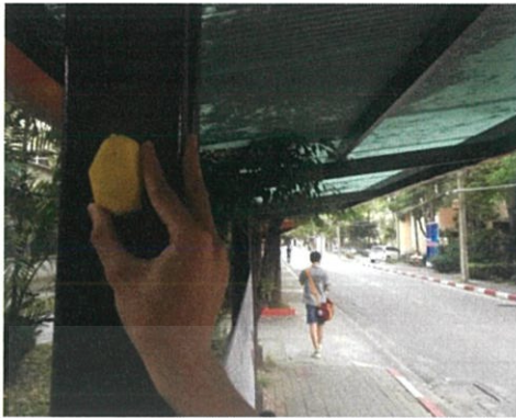
รูปที่ 4.1 ติดตั้งบีดคอน
