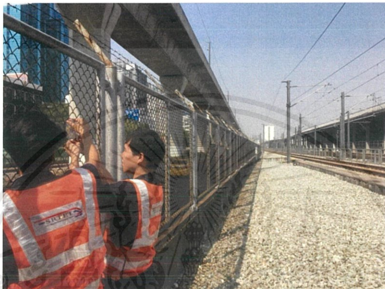
รูปที่ 3.15 ติดตั้งอุปกรณ์ปล่อยสัญญาณบลูทูธ ณ บริเวณเทสแทรคแอร์พอร์ต เรล ลิงค์
