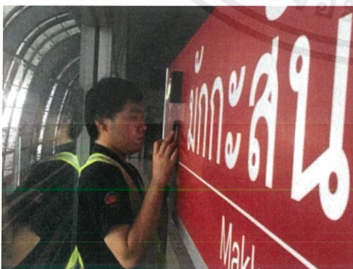
รูปที่ 4.3 ติดตั้งอุปกรณ์ปล่อยสัญญาณบลูทูธที่สถานีรถไฟฟ้ามักกะสน
