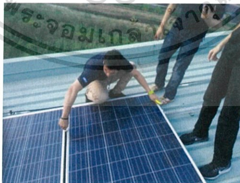
รูปที่ 4.70 เมื่อนำแผงใหม่ใส่เข้าที่เดิมก็ขันน็อต
