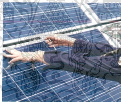
รูปที่ 4.66 ทำการไขน็อตจับยึดแผง
