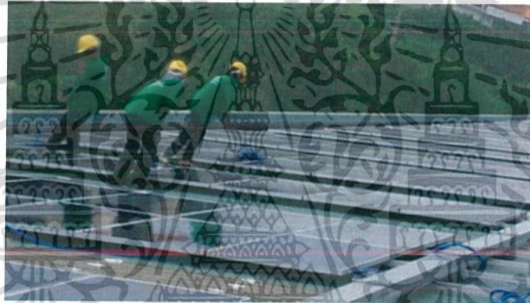
รูปที่ 4.72 ไล่น้ำออกจากหน้าแผง
