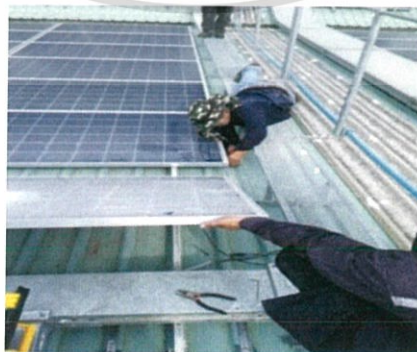
รูปที่ 4.67 ทำการถอดหัว MC4
