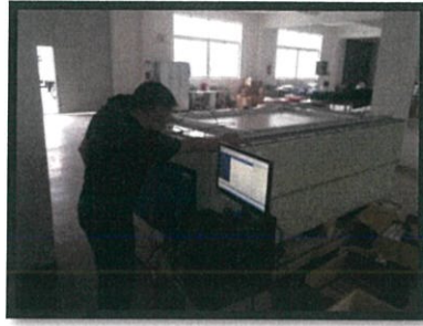
รูปที่ 3.46 ต่อสายที่ Junction box
