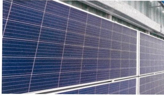
รูปที่ 3.30 แผงเปื้อนสี
