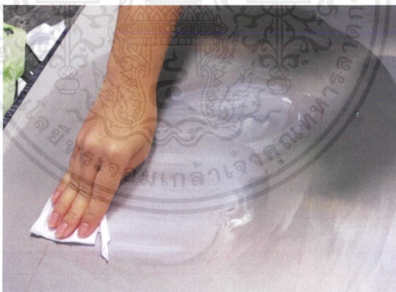
ภาพที่ 3.83 ภาพการเช็ดสีผสมน้ำมันสน
