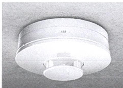
ภาพที่ 7-13 ระบบตรวจจับความร้อน Heat Detector
