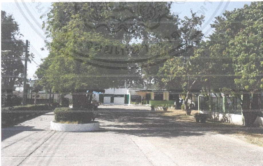
ภาพที่ 3-13 ภาพแสดงผังบริเวณด้านหน้าอาคารอำนวยการ ที่มา ภาพถ่ายจากการไปศึกษาโครงการ (สืบค้นวันที่ 19 ธันวาคม)
