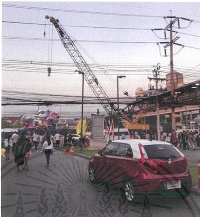
ภาพที่ 2.5 ภาพพื้นที่ที่กำลังก่อสร้างในเขตแจ้งวัฒนะ ภาพถ่ายโดยผู้จัดทำศิลปนิพนธ์, 2562
