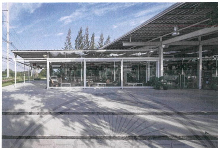
ภาพที่ 3-1 แสดงอาคารร้านอาหารและขายสินค้าโครงการ Coro Field
