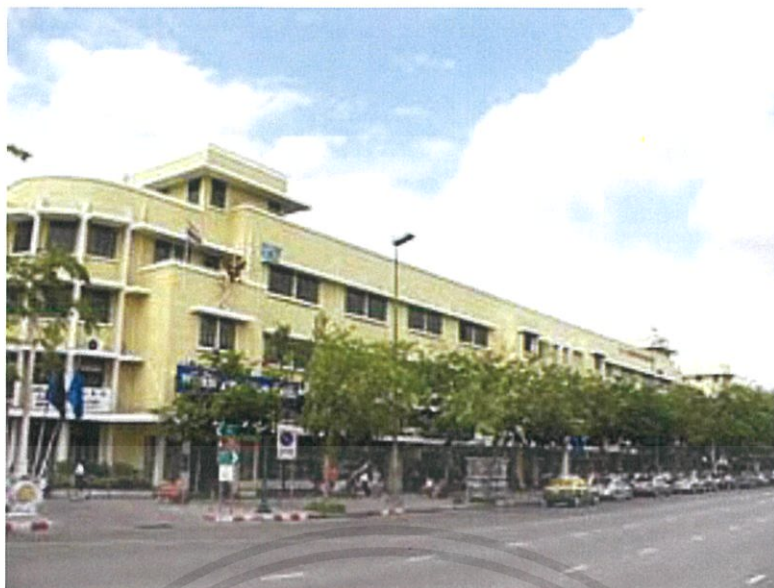
รูปที่ 16 : อาคารบริเวณถนนราชดำเนิน (2)
