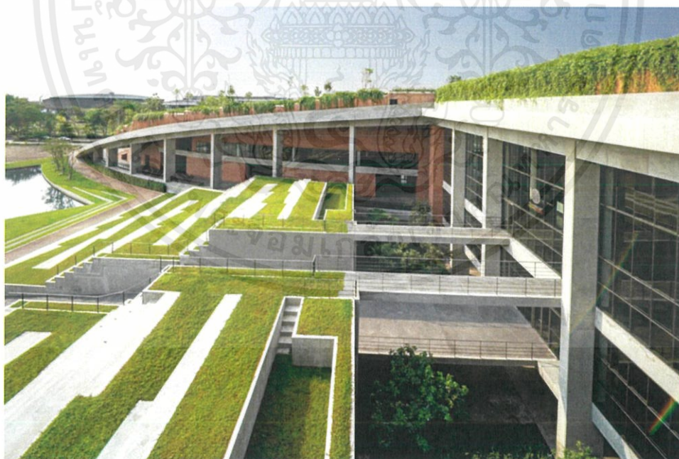
รูปที่ 77 รูปด้านข้างของอาคาร สวนปวย อังภากรณ์ ส่วนด้านหน้าอาคาร
