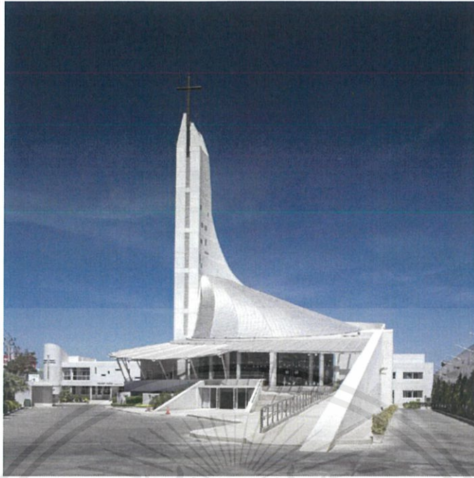
รูปที่ 35 ภาพถ่ายการสำรวจสถานที่จริง ณ วัดศีลมหาสนิท (2)
