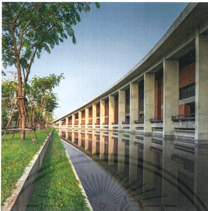
รูปที่ 78 รูปด้านข้างของอาคาร สวนปวย อังภากรณ์
