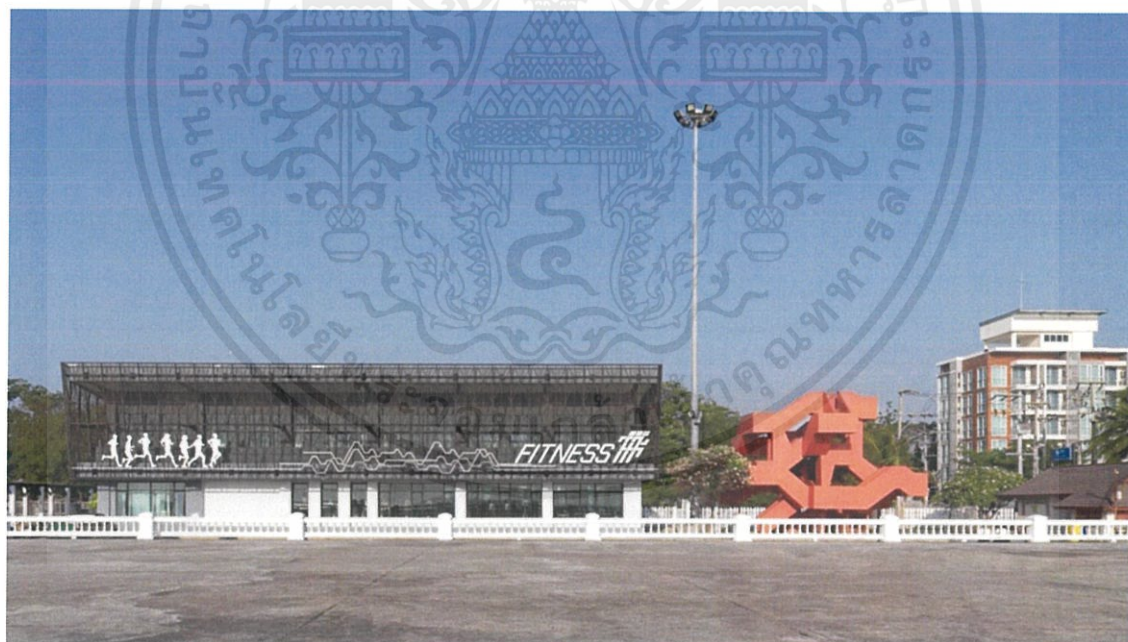
รูปที่ 83 ภาพมุมมองบริเวณรอบๆอาคาร 10 Cal Tower
