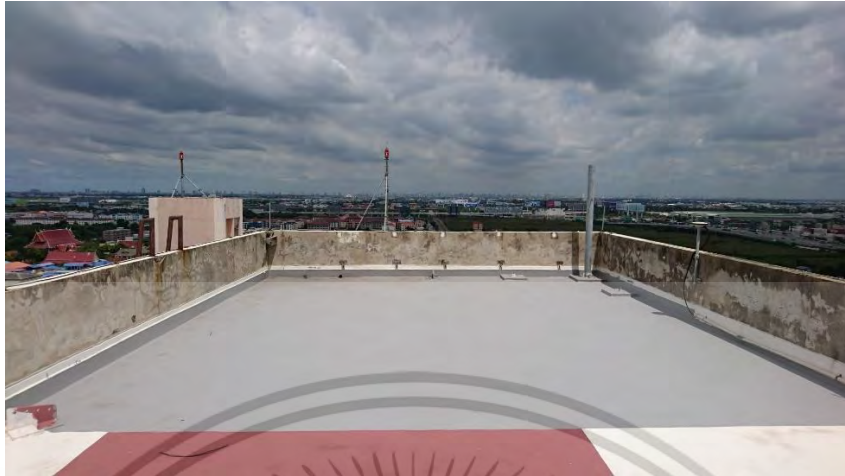
ภาพที่ 3.93 บริเวณเหนือห้องสถานภาคพื้นดินก่อนทำการติดตั้งเสาทาวเวอร์และสายอากาศ
