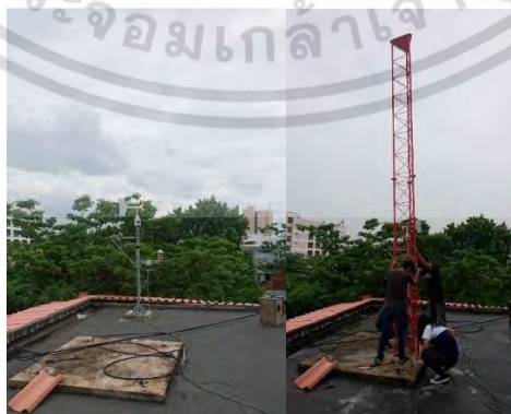
ภาพที่ 3.98 บริเวณดาดฟ้าอาคารภาควิชาวิศวกรรมโทรคมนาคมขณะทำการติดตั้งเสาทาวเวอร์
