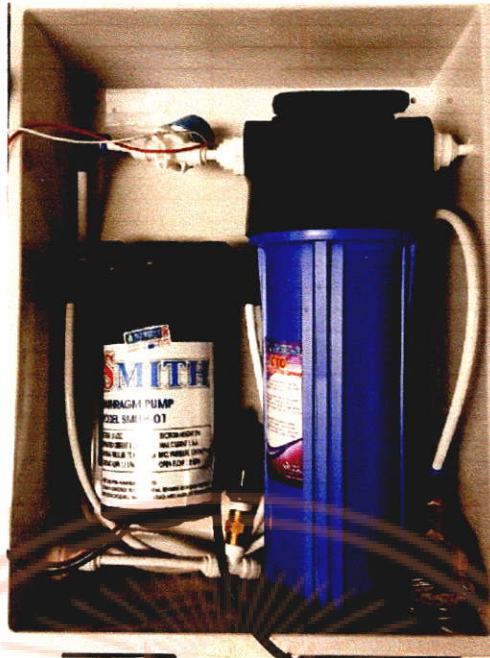
รูปที่ 4.13 ระบบปั้มน้ำพ่นน้ำและสารอาหาร
