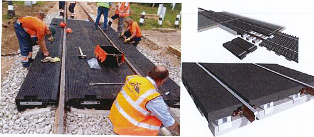
ภาพที่ 2.15 ตัวอย่างแผ่นยางปูทางผ่านเสมอระดับทางรถไฟของบริษัท Trelleborg [23] 4. บริษัท Rosehill Rail [24] ประเทศอังกฤษ
