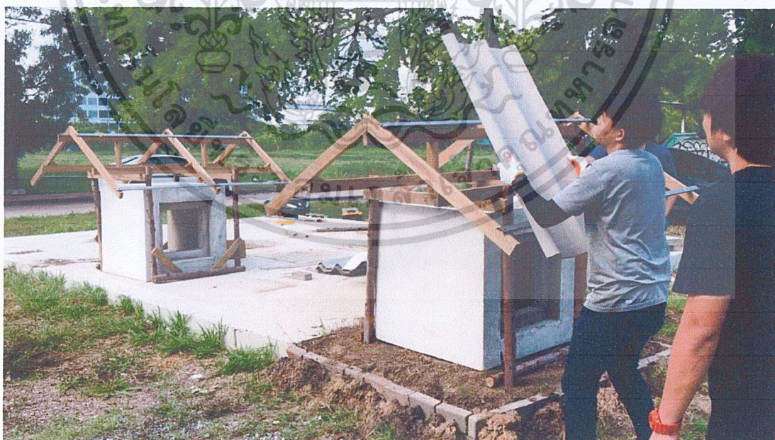
รูปที่ 3. 26 กล่องทดลองที่ติดตั้งหลังคากระเบื้องลอนคู่เพื่อจำลองสถานการณ์บ้านดิน ที่มา: ผู้วิจัย (2563)
