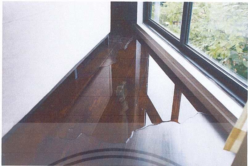
รูปที่ 2.42 น้ำฝนที่ซึมเข้าภายในบ้านตามขอบหน้าต่าง ที่มา : https://www.kswood.com/home-tips/5-เทคนิค-เตรียมความพร้อม
