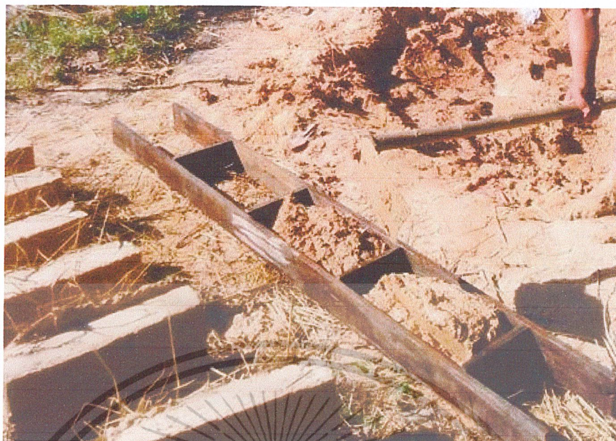
รูปที่ 2.29 การนำดินที่ผสมแล้วอัดเข้าแม่พิมพ์ไม้ ที่มา: https://www.baannoi.com/images/5513.jpg
