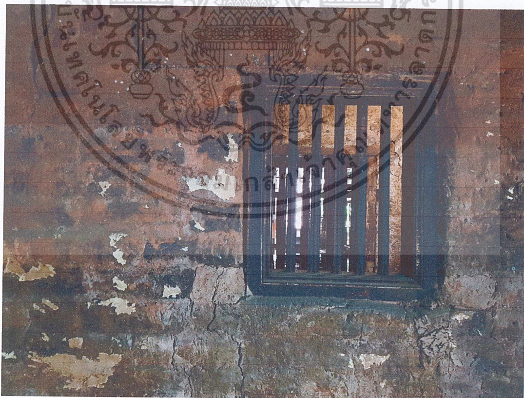
รูปที่ 2.12 ผนังบ้านดินที่เสื่อมสภาพเกิดการแตกร้าว
