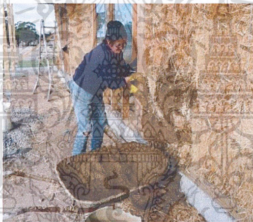
รูปที่ 2.38 การใช้ฟางก่อบนด้วยดิน
