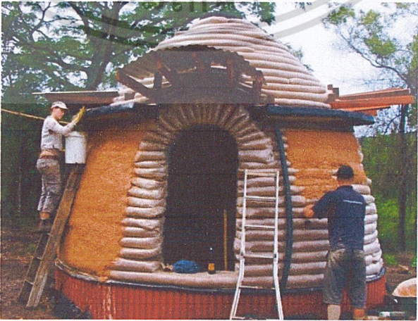
รูปที่ 2.37 การก่อสร้างด้วยการใช้กระสอบ
