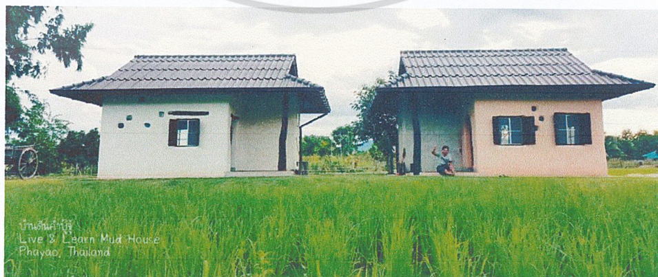
รูปที่ 2.24 หลังคาบ้านดินที่มุงกระเบื้องลอนคู่
