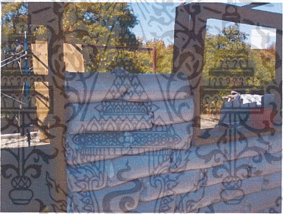
รูปที่ 2.36 การก่อสร้างด้วยการใช้กระสอบ ที่มา: https://www.bansuanporpeang.com/node/29188
