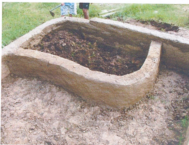
รูปที่ 2.20 ฐานรากบ้านดินที่สร้างจากดินดิบ
