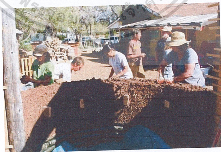
รูปที่ 2.32 การปั้นผนังบ้านดิน
