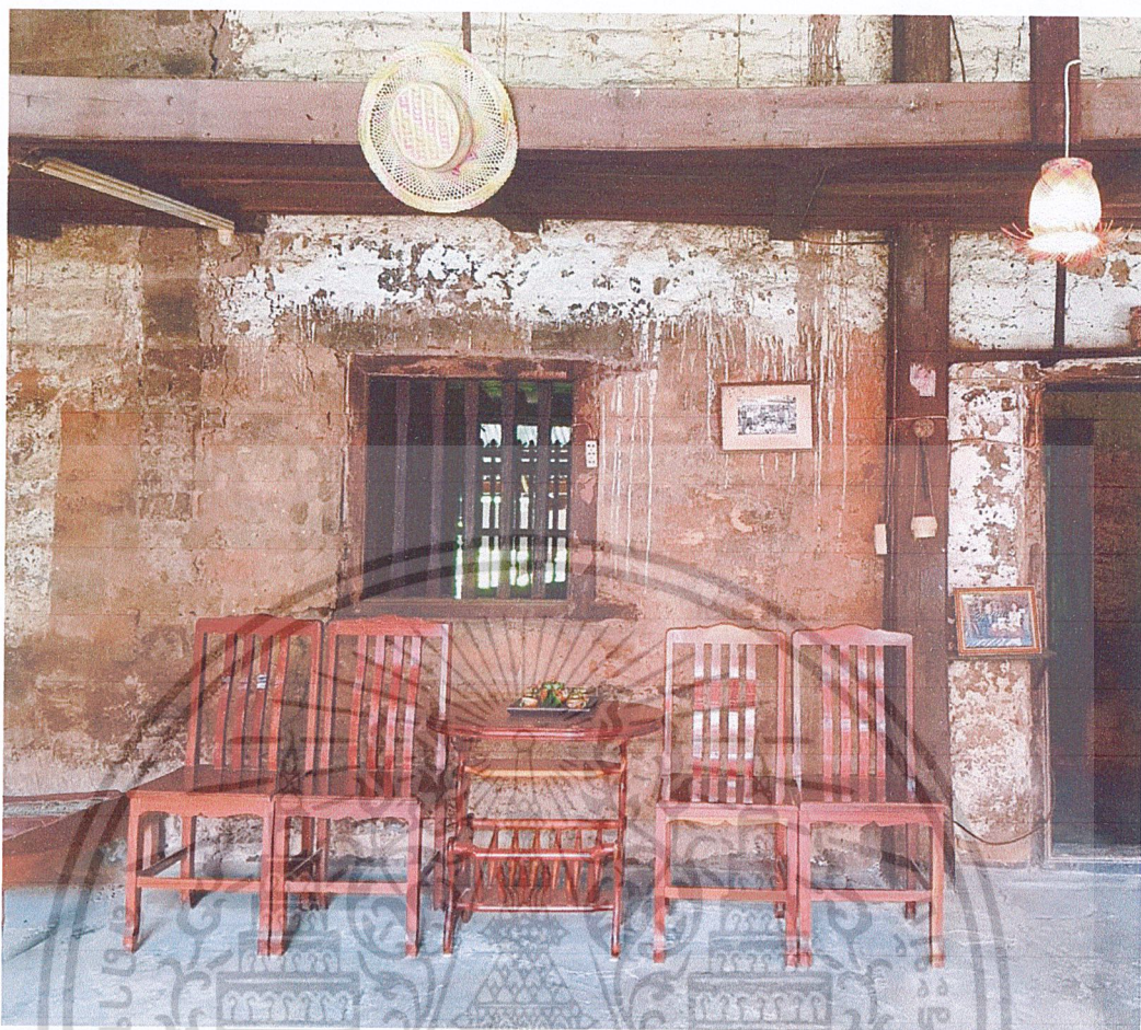
รูปที่ 2.13 ผนังบ้านดินที่เสื่อมสภาพ
