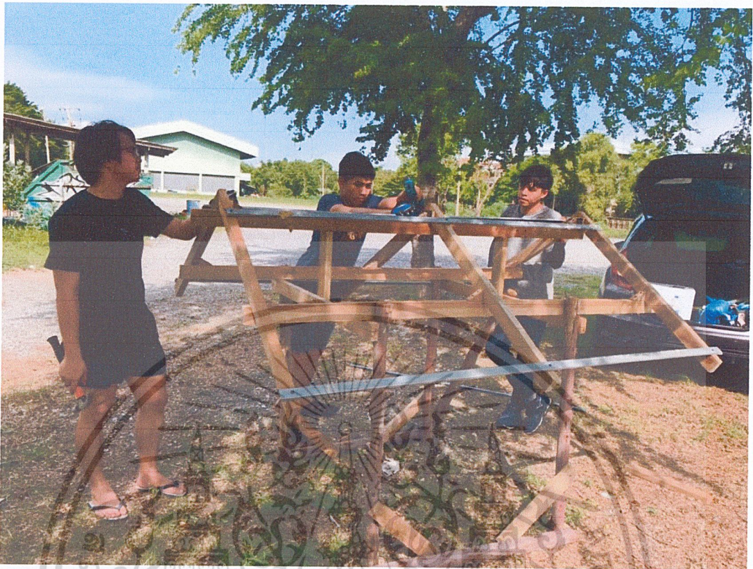
รูปที่ 3.23 การประกอบโครงสร้างหลังคาที่จำลองสถานการณ์บ้านดิน ที่มา: ผู้วิจัย (2563)
