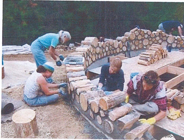
รูปที่ 2.34 การใช้เศษไม้หรือหินในการสร้างบ้านดิน
