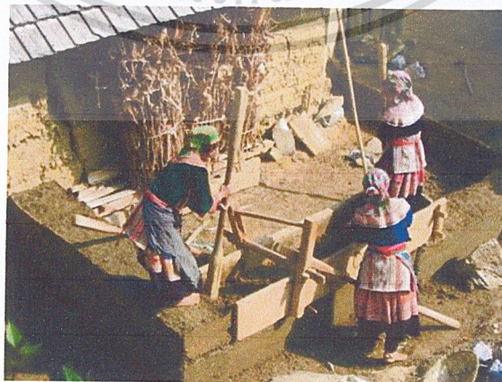
รูปที่ 2.35 การก่อสร้างด้วยเทคนิคดินอัด
