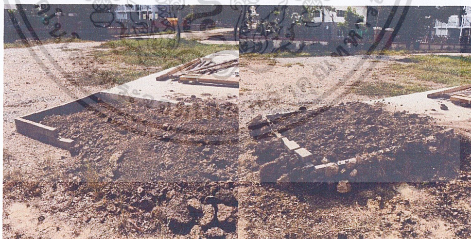
รูปที่ 3.22 การทำฐานพื้นดินเหียวอัด พื้นที่ขนาด 1.50 X 1.50 เมตร เพื่อจำลองฐานพื้นบ้านดิน ที่มา: ผู้วิจัย (2563)
