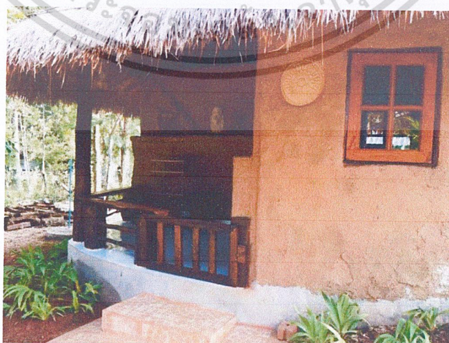
รูปที่ 2.22 ฐานรากคอนกรีตของบ้านดิน
