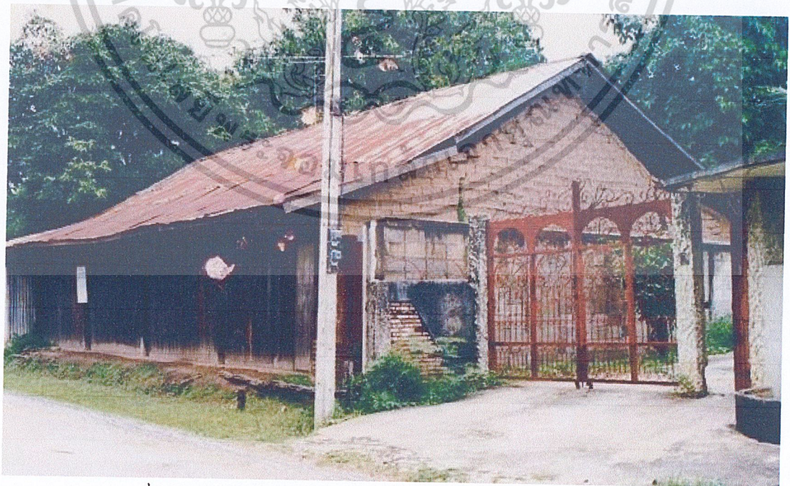
รูปที่ 2.1 อาคารห้องแถวดินดิบเก่าที่ อำเภอมือง จังหวัดมหาสารคาม
