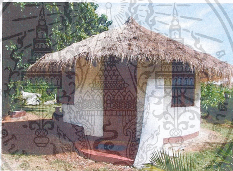
รูปที่ 2.23 หลังคาบ้านดินที่มุงด้วยหญ้า
