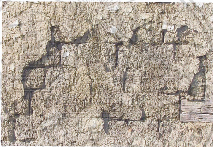
รูปที่ 2.10 ผนังบ้านดินที่เสื่อมสภาพ
