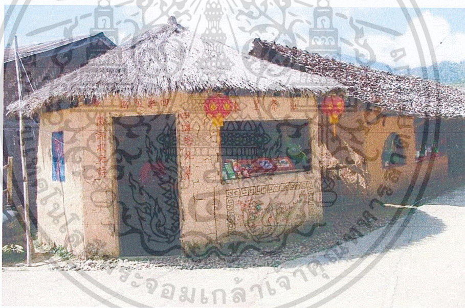
รูปที่ 2.15 ผนังบ้านดินเกิดการแตกร้าวและเกิดเชื้อราบริเวณผนังที่เชื่อมต่อกับฐานบ้านดิน ที่มา : https://www.chiangmainews.co.th/page/archives/553661/
