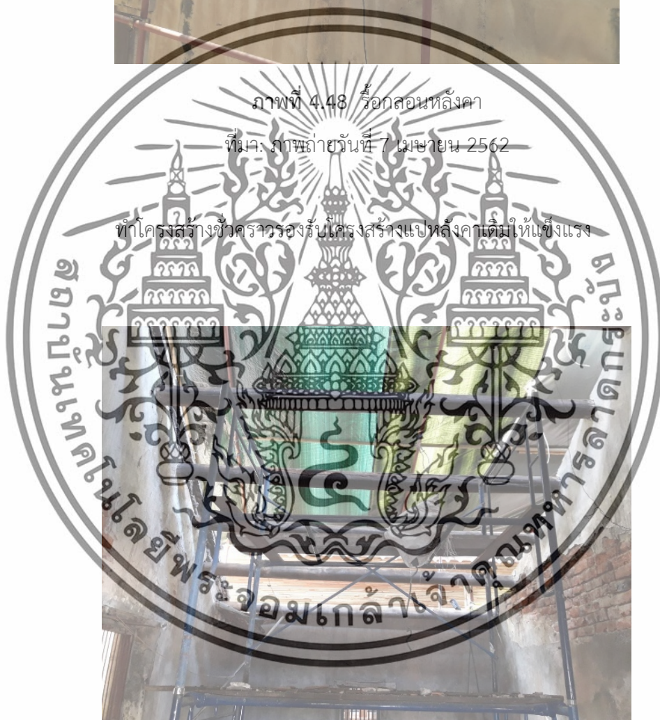
ภาพที่ 4.49 ทำโครงสร้างชั่วคราวค้ำโครงสร้างหลังคาเดิม ที่มา: ภาพถ่ายวันที่ 9 เมษายน 2562
