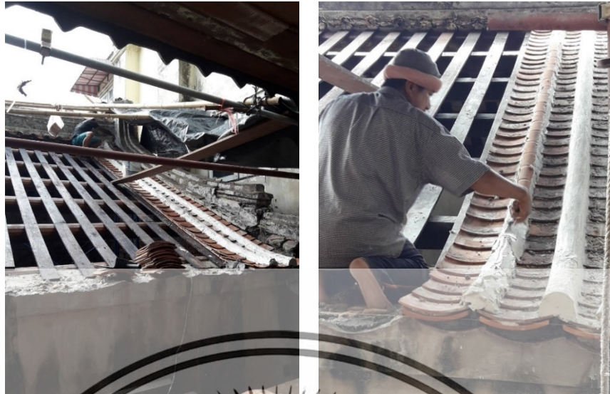
ภาพที่ 4.52 ปูกระเบื้องตัวหงาย(ซ้าย) กระเบื้องตัวคว่ำฉาบปูนขาวทับ(ขวา) ที่มา: ภาพถ่ายวันที่ 12 กรกฎาคม 2562
