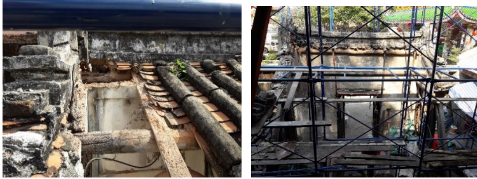
ภาพที่ 4.35 รื้อกระเบื้องหลังคา(ซ้าย) รื้อโครงสร้างบริเวณซุ้มประตูหลัง (ขวา)
