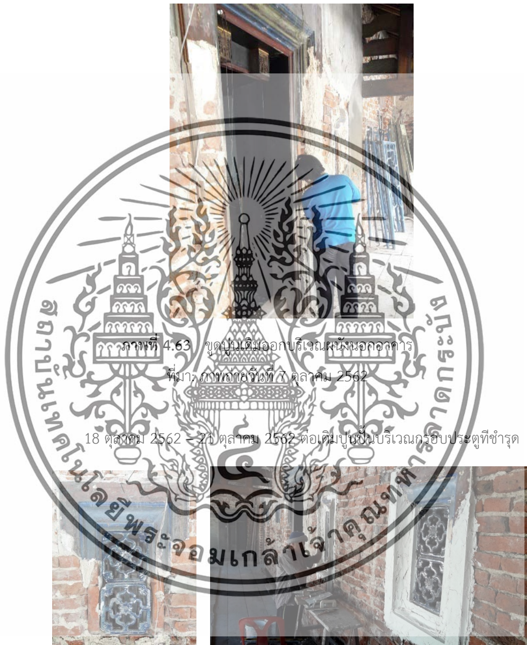
ภาพที่ 4.64 ปูนปั้นบริเวณกรอบหน้าต่างที่ชำรุด(ซ้าย) ทำปูนปั้นกรอบหน้าต่าง (ขวา)
