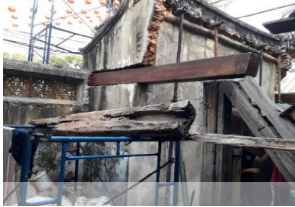
ภาพที่ 4.37 เปลี่ยนคานเดิมจากไม้ที่ผุ ที่มา: ภาพถ่ายวันที่ 12 กุมภาพันธ์ 2562
