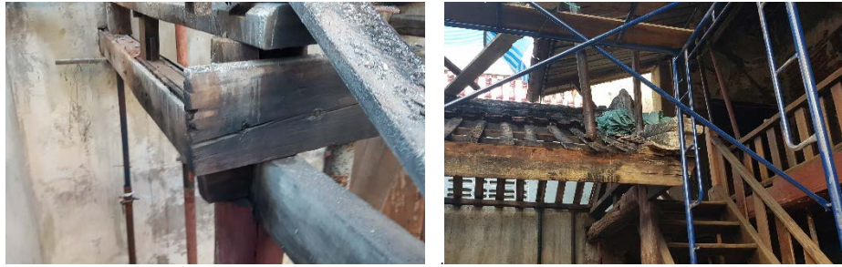
ภาพที่ 4.11 โครงสร้างเหล็กรับโครงเดิม(ซ้าย) เสริมโครงสร้างเหล็กรับโครงเดิม(ขวา)
