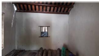
ภาพที่ 4.62 ฉาบปูนขาวภายในห้องชั้นที่ 2
