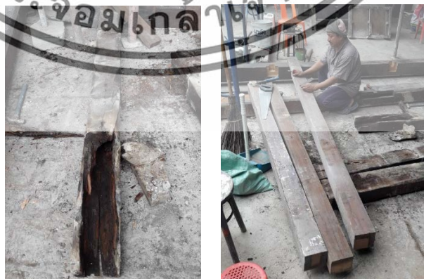
ภาพที่ 4.79 ตงไม้เดิมที่ผุ (ซ้าย) เตรียมไม้ใหม่ทำตงพื้น (ขวา)
