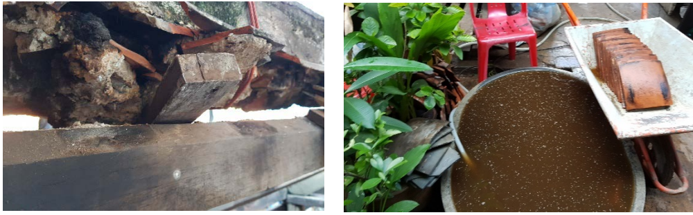
ภาพที่ 4.13 เปลี่ยนนอกโกไม้ใหม่(ซ้าย) ทำความสะอาดกระเบื้องหลังคา(ขวา)
