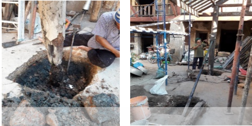
ภาพที่ 4.28 เสอาอาคารเดิมที่ผู้ (ซ้าย) เหล็กค้ำโครงสร้างชั่วคราวรับโครงสร้างไม้เดิม (ขวา) ที่มา: ภาพถ่ายวันที่ 26 พฤศจิกายน 2561
