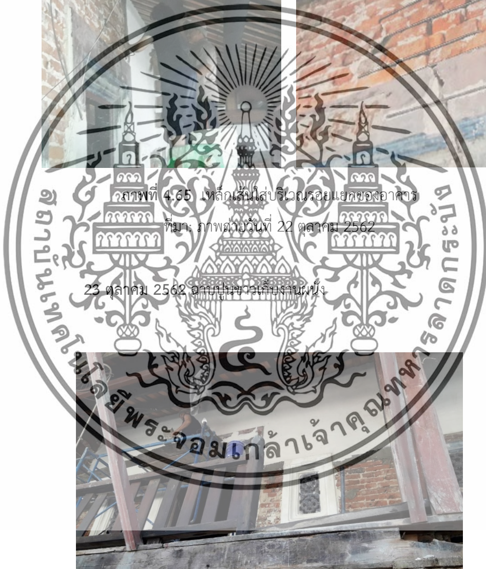
ภาพที่ 4.66 ฉาบปูนขาวเก็บงานผนัง ที่มา: ภาพถ่ายวันที่ 23 ตุลาคม 2562
