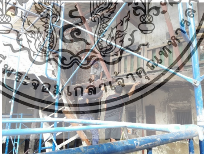
ภาพที่ 4.74 คานพื้นชั้นที่ 2 ที่เคลื่อนจากหัวเสา
