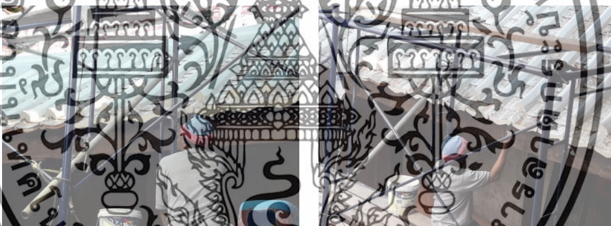
ภาพที่ 4.22 ฉาบปูนขาวแทนการติดชายอุดดอกไม้ ที่มา: ภาพถ่ายวันที่ 13 พฤศจิกายน 256
