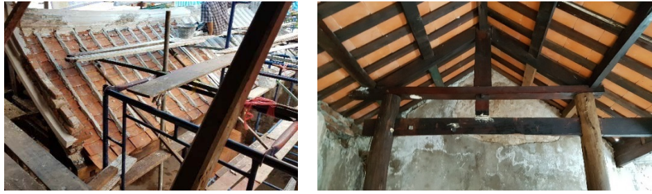
ภาพที่ 4.30 ปูกระเบื้องหลังคา
