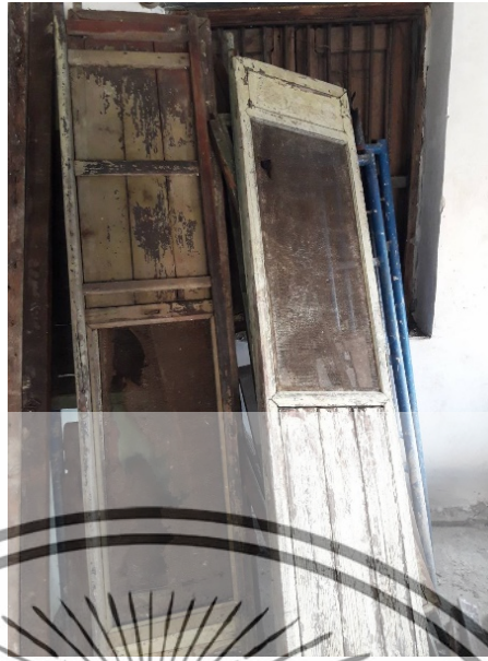
ภาพที่ 4.69 ช่องแขมรวงกบประตูโถงชั้นที่ 2 ที่มา: ภาพถ่ายวันที่ 22 พฤศจิกายน 2562
