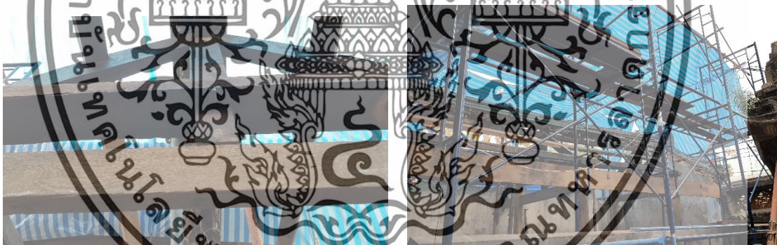
ภาพที่ 4.29 ทำการเปลี่ยนอเส(ซ้าย) ทำการเปลี่ยนจันทัน(ขวา) ที่มา: ภาพถ่ายวันที่ 29 พฤศจิกายน 2561
