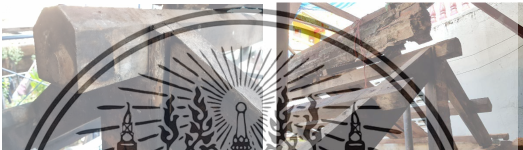
ภาพที่ 4.14 ถอดปูนปั้นสันหลังคา
