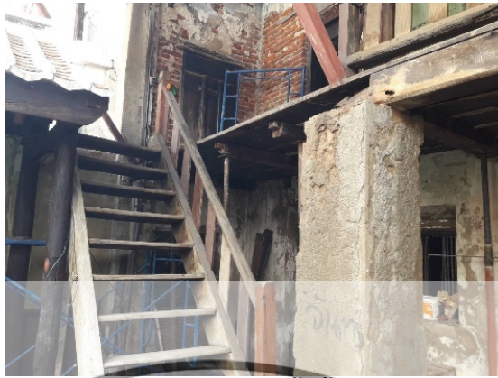
ภาพที่ 4.75 นำคานพื้นชั้นที่ 2 ออก ที่มา: ภาพถ่ายวันที่ 2 กันยายน 2562
