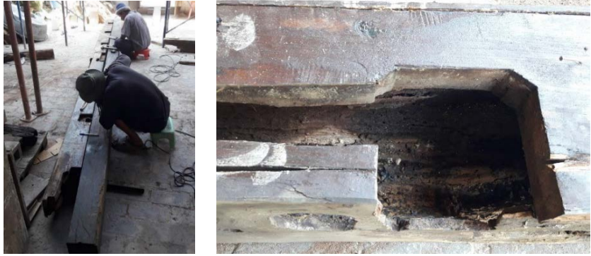
ภาพที่ 4.77 ทำคานไม้ใหม่(ซ้าย) เชาะร่องไม้เพื่อเสียบเข้ากับตงตัวผู้(ขวา)
