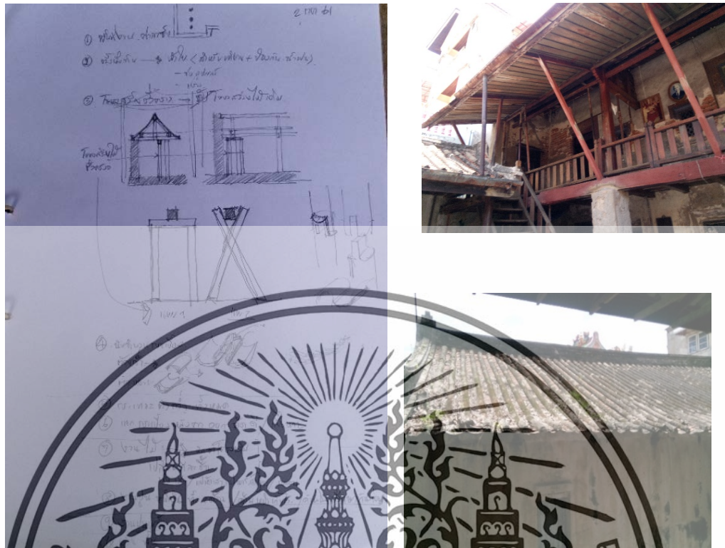
ภาพที่ 4.7 แนวคิดการทำเหล็กค้ำโครงสร้างชั่วคราวรับโครงสร้างไม้เดิม (ซ้าย) ลักษณะโถงบ้านจีน ทั้งวงฮะ (ขวาบน) หลังคาบ้านจีนทั้งวงฮะ(ขวาล่าง) ที่มา: ภาพถ่ายวันที่ 2 สิงหาคม 2561
