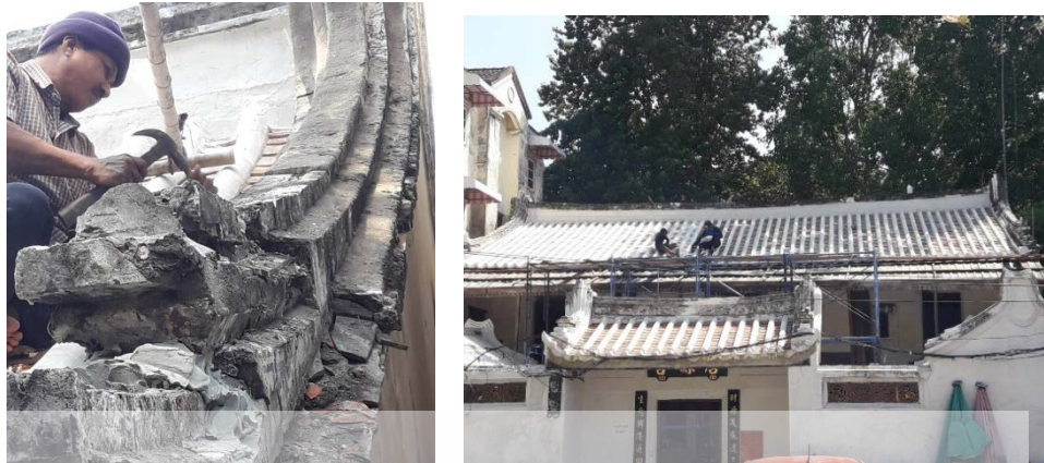
ภาพที่ 4.55 ซ่อมแซมปูนปั้นเดิมที่ชำรุด(ซ้าย) เก็บงานหลังคา(ขวา)
