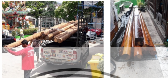
ภาพที่ 4.60 จัดเตรียมไม้เพื่อใช้ในการก่อสร้าง
