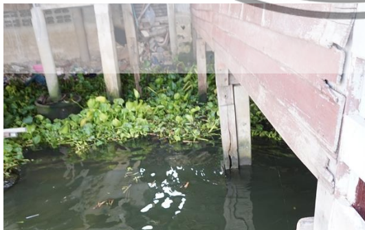
รูปที่ 4.65 การใช้เสาคอนกรีตเสริมความแข็งแรง
