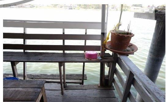
รูปที่ 4.66 การใช้เสาเหล็กเป็นเสารับหลังคา
