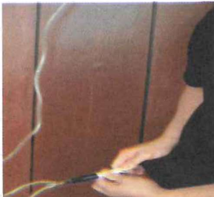
รูปที่ 2.19 เมื่อปล่อยน้ำยาเข้าจนหมดใช้เวลา 5-10 นาที เสร็จแล้วปิดวาล์ว และปิดตัวหนีบสี น้ำเงินที่สายน้ำยาใหม่
