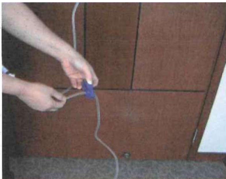
รูปที่ 2.17 ปิดตัวหนีบสีน้ำเงินที่สายปล่อยน้ำทิ้ง
