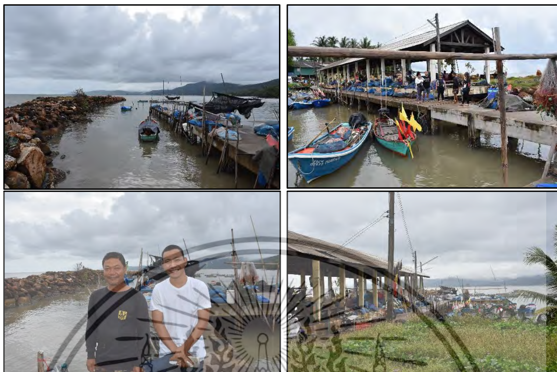
ภาพที่ 4.20 สภาพบริเวณท่าเทียบเรือประมงชายฝั่ง หมู่ที่ 3 คลองหิน ตำบลหาดเล็ก อำเภอลองใหญ่ จังหวัดตราด
