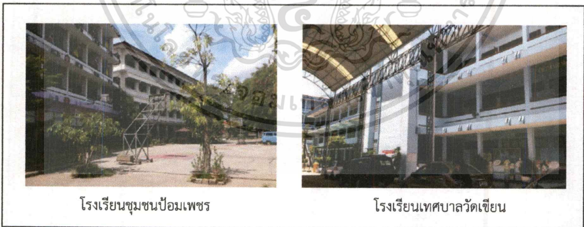
ภาพที่ 5.1 แสดงตัวอย่างสภาพแวดล้อมทางกายภาพอาคารเรียน
