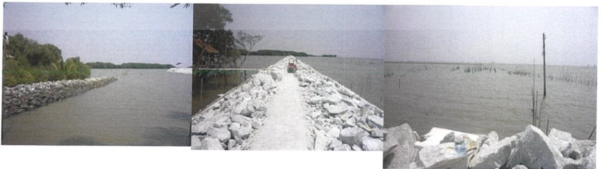
ภาพที่ 4.5 การป้องกันการกัดเซาะชายฝั่งจากการทำเขื่อนหินทิ้ง
